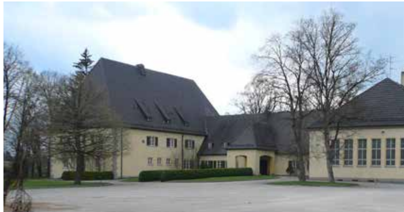
Ehemaliges Offizierskasino der Sheridan-Kaserne Foto: Barbara Freihalter
