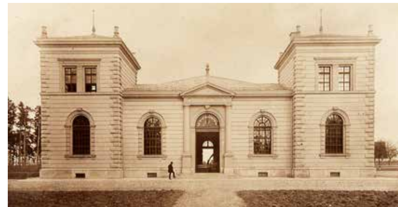
Wasserwerk am Hochablaß, Ansicht von Westen, 1880 Quelle: Stadt Augsburg
