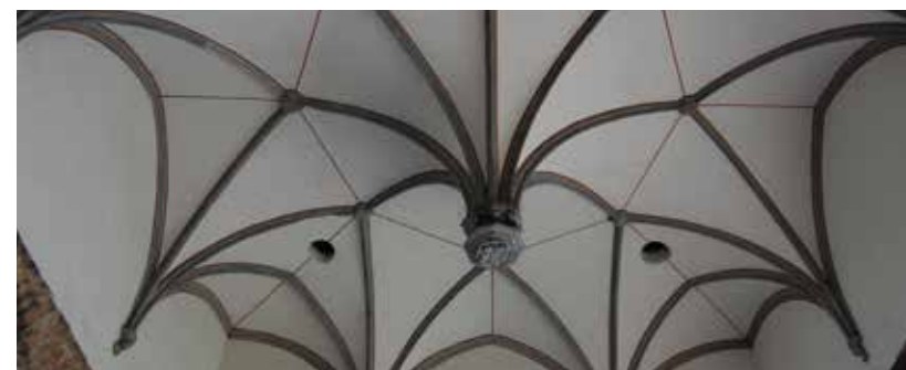
Gewölbe der Durchfahrt Foto: Ulrich Heis
