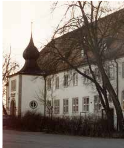
Ehemaliges Offizierskasino der Somme-Kaserne, Ansicht von Nordost Quelle: Architekturmuseum Schwaben
