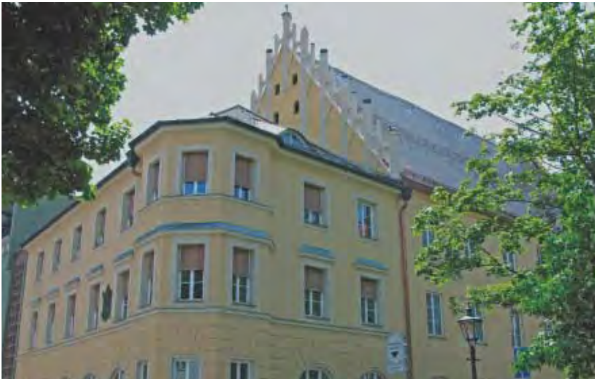
Peutingerstraße 25: Nordseite und Ostgiebel, sowie angebauter Ostflügel.
