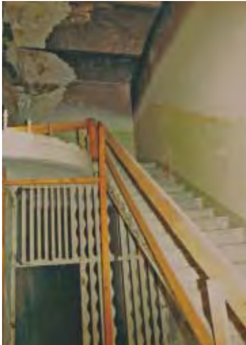
Kurhaus: Originalsituation Treppe im Kopfbau, 1990.
