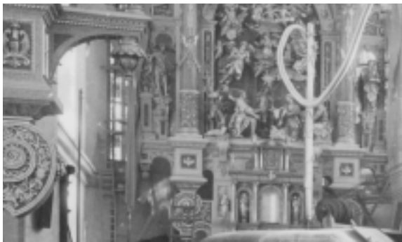
St. Ulrich und Afra: Ausschachtungsarbeiten mit einem Bagger in der Vierung, Oktober 1961.
