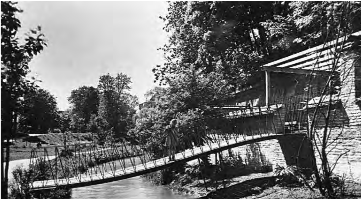
Ehemaliger Roter Torwall nach Umgestaltung durch den Gartenbauarchitekten Ludwig Roemer, Brücke zum Rosengarten
