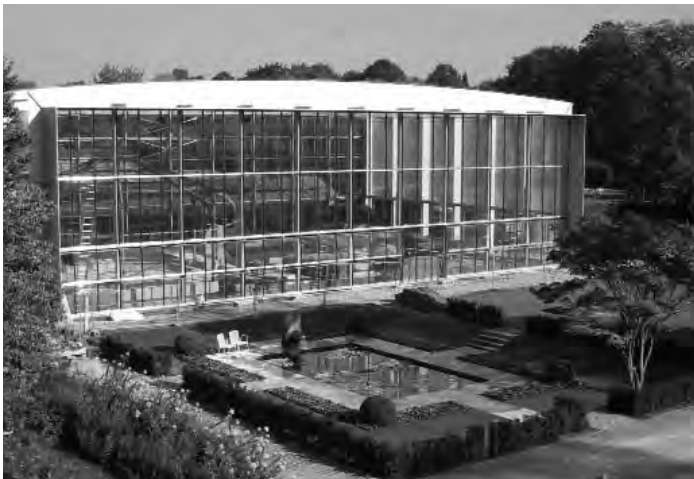
Neues Tropenhaus mit neuer Dachtechnik
