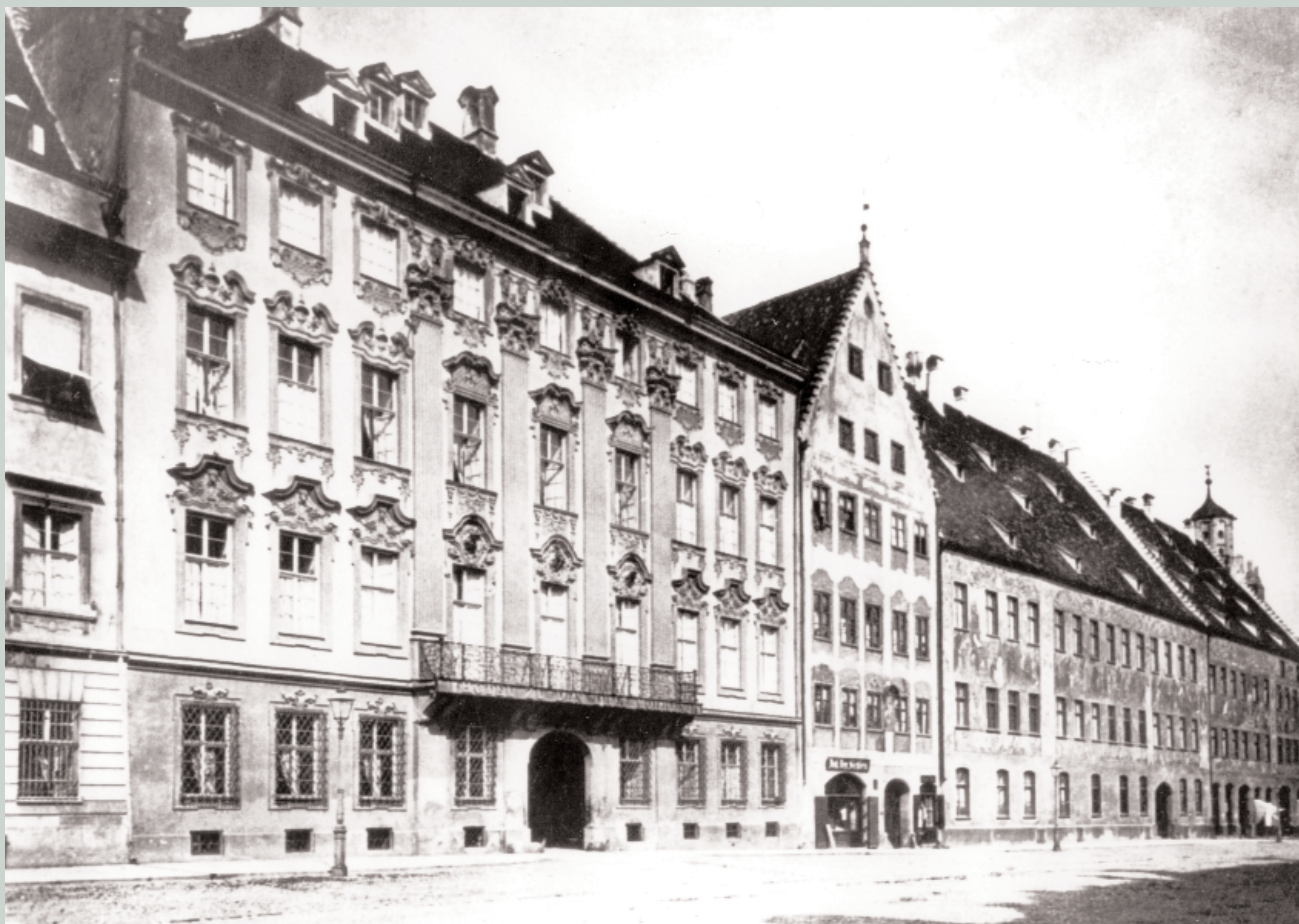
Herwart-Fugger Palais (links): Fassade von 1868
