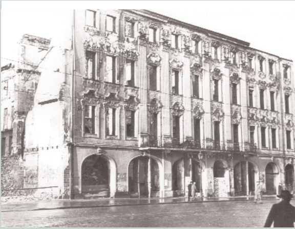
Herwart-Fugger Palais: Zerstörte Fassade von 1945
