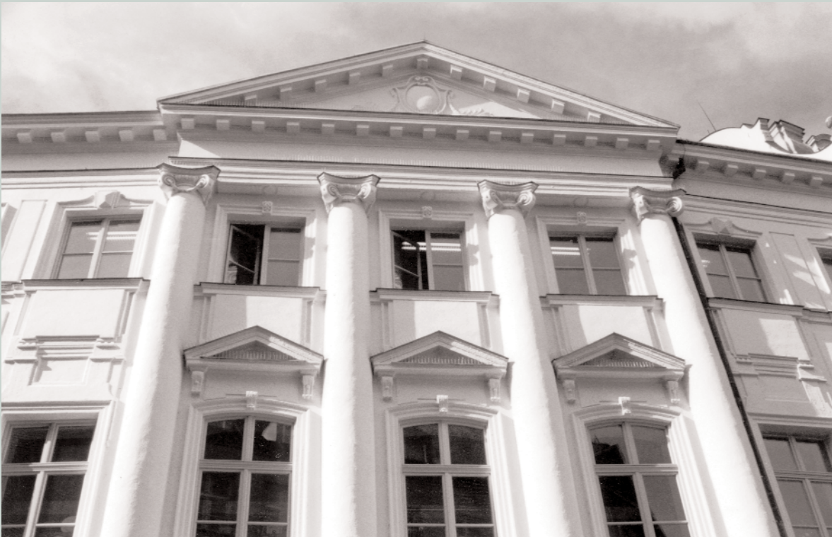
Nordfassade Philippine-Welser-Straße: Kolossalordnung
