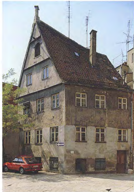
Schmiedgasse 19: Vor Abbruch
