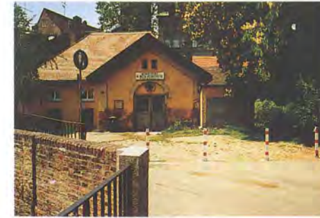
Unterer Graben 1 vor der Sanierung
