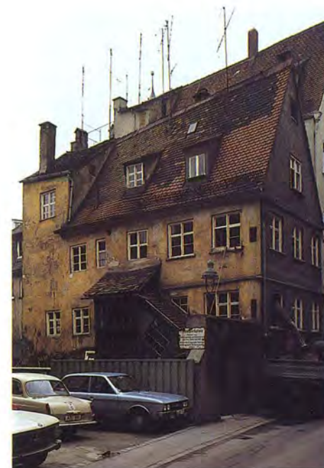
Pfladergasse 10 vor Sanierung
