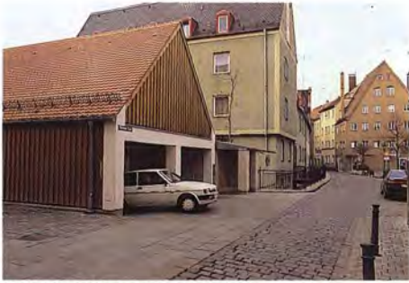
Tiefgarage Vorderer Lech, Einfahrt
