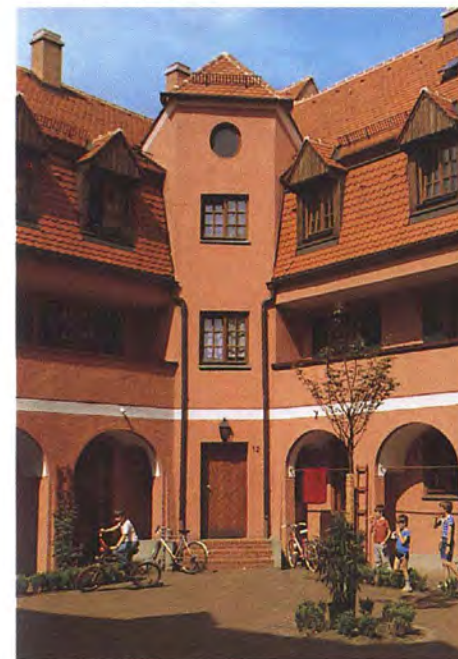
Kapitelhof nach Sanierung
