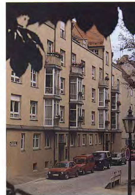
Neubau an der Vogelmauer
