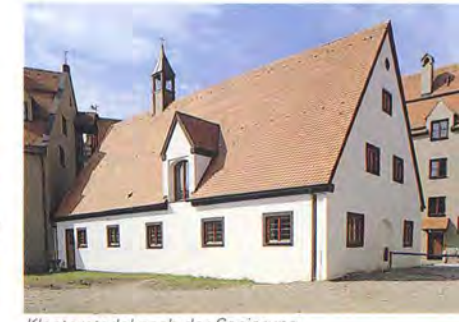
Klosterstadel nach der Sanierung
