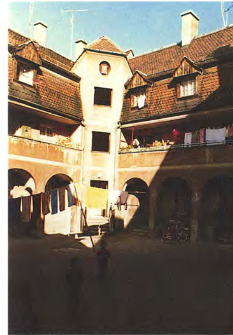
Kapitelhof vor Sanierung
