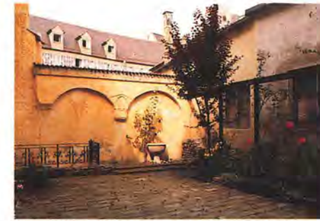
Innenhöfe am Hinteren Lech (vorher – nachher)
