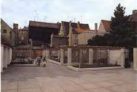
Grünanlage über der Tiefgarage
