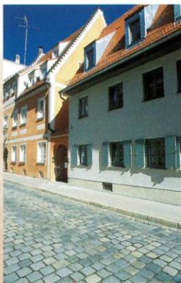
Zwerchgasse 9 und 11, alter und neuer Zustand
