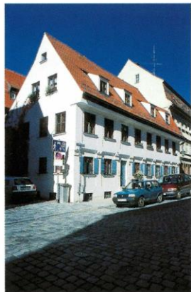
Spitalgasse 18, alter und neuer Zustand
