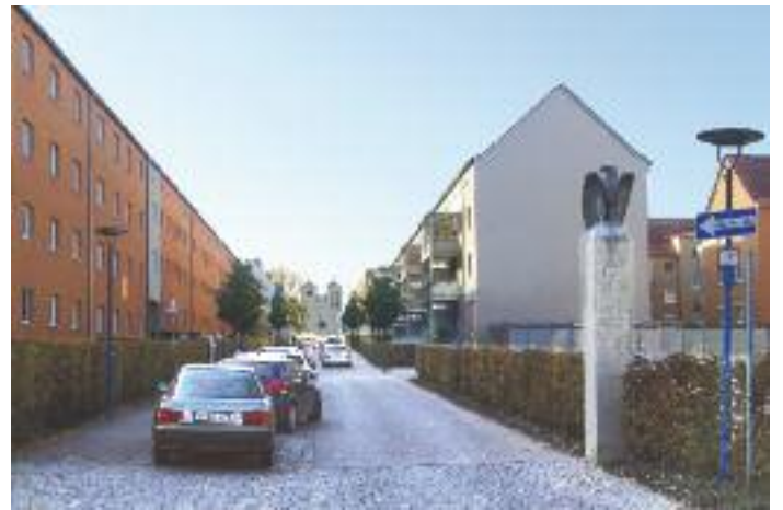
... und nach dem Umbau 1
