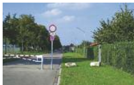
Gesperrtes Teilstück der Äußeren Uferstraße 3
