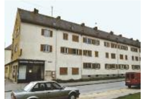
Schönbachstraße 22 ② wurde abgerissen ...
