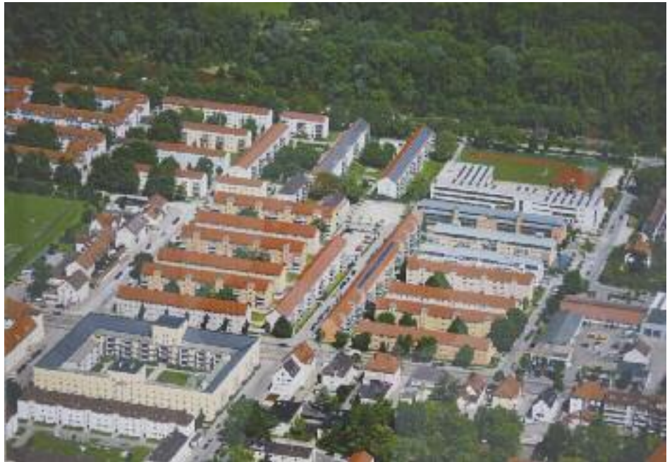
Photovoltaik / Solaranlagen auf den nach Süden gerichteten Dachflächen 2010
