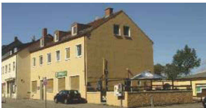
Leerstehende Gaststätte an der Tauscherstraße 1
