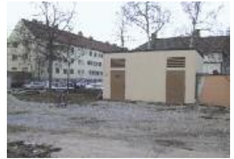
Drei-Auen-Platz 1 ... vor der Sanierung
