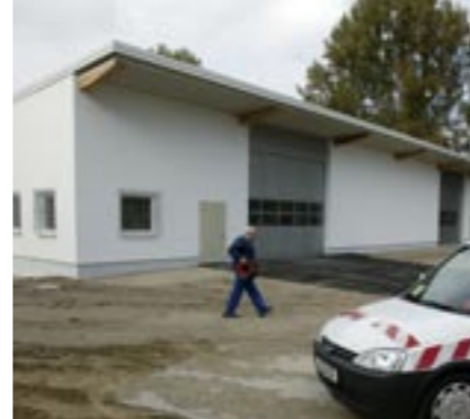
Der Betriebshof in der Schwimmschulstraße.
